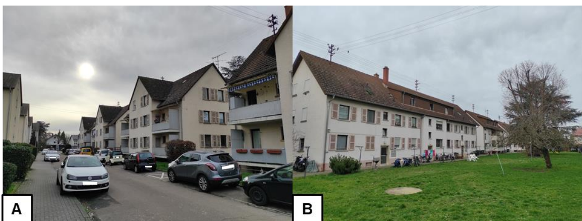
(A) Blick entlang der Otto-Häussler-Straße; (B) Blick in den Innenhof| Quelle: Eigene Aufnahmen vom 15.02.2024
