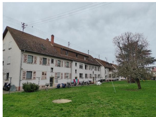
Gebäudeerschließung vom Innenhof
